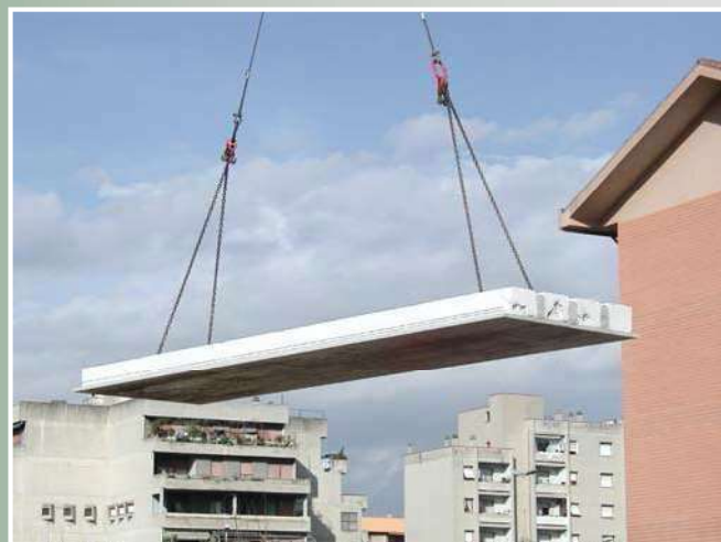
Fasi di montaggio della lastra Precomp
