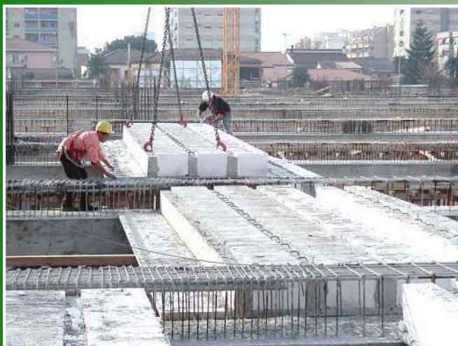
Fasi di montaggio della lastra Precomp
