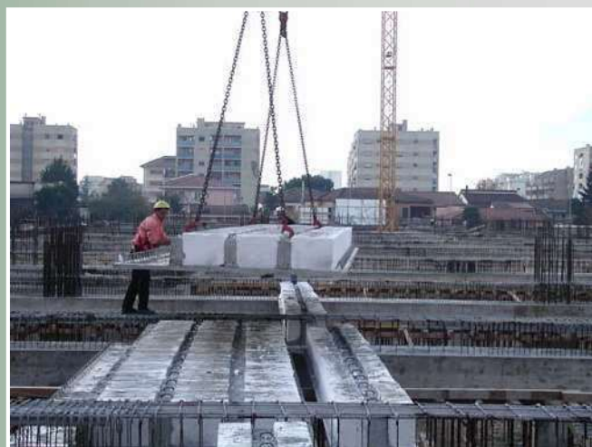
Fasi di montaggio della lastra Precomp
