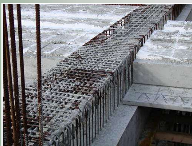
Fasi di montaggio della lastra Precomp
