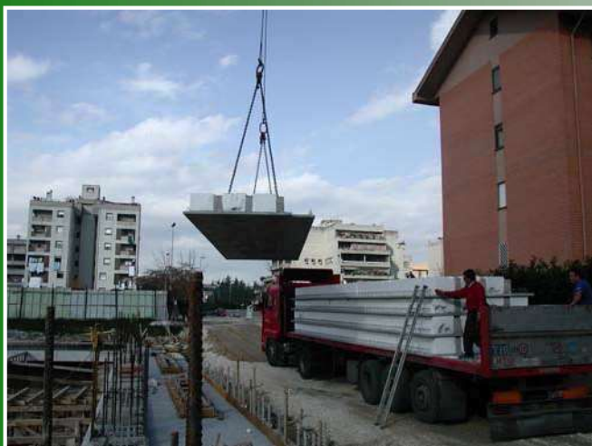
Fasi di montaggio della lastra Precomp
