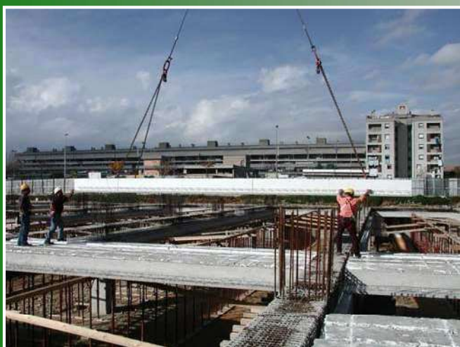
Fasi di montaggio della lastra Precomp
